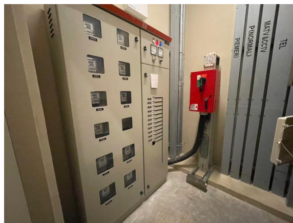
รูปที่ 2-58 มิเตอร์ไฟแต่ละชั้น
