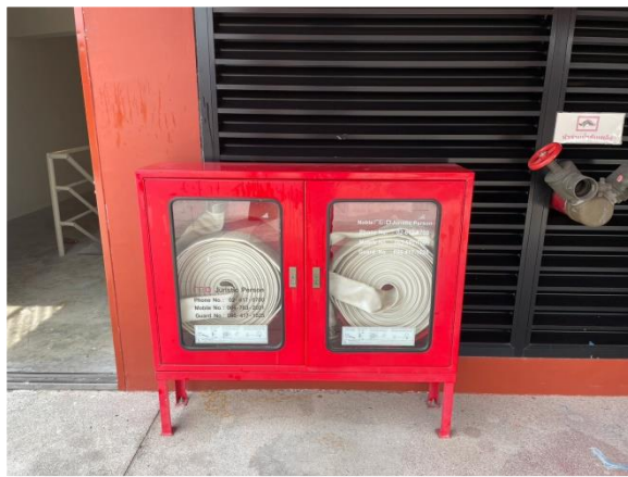
รูปที่ 2-29 ตู้เก็บสายน้ำดับเพลิงชั้นดาดฟ้า
