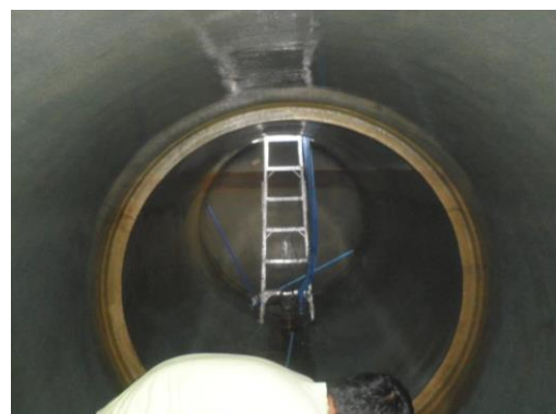
รูปที่ 2-68 ล้างถังเก็บน้ำสำรอง
